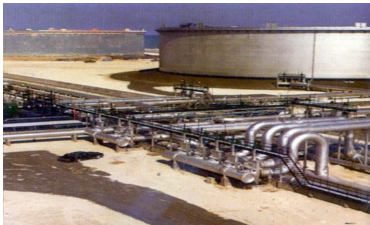
Рис. 7.2. Трубопроводы доставляют нефть на нефтебазу, подобную изображенной на рисунке, где продукт хранится до транспортировки на нефтеперерабатывающий завод
